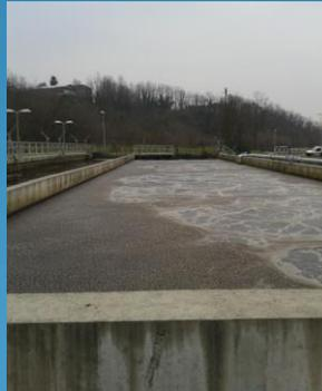
Infine un'ultima decantazione provvede al deposito degli scarti prodotti dai batteri. L'acqua è ora depurata ed è pronta per essere immessa nuovamente nel fiume. Poi abbiamo fatto alcuni esperimenti per verificare la qualità dell'acqua in entrata al depuratore e in uscita. Infine siamo andati a vedere al microscopio alcuni batteri presenti nell'acqua e nelle vasche di depurazione. Abbiamo trascorso una bellissima e interessantissima mattinata!
