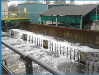
Poi l'acqua viene raccolta per la sedimentazione dei fanghi e successivamente passa al trattamento biologico per il quale si utilizzano batteri che si nutrono di materie organiche.
